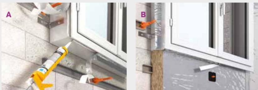
Embrochez l'isolant RT PLUS 032 sur l'appui intermédiaire AcoustiZAP® 2 NÉO et positionnez la Pastille RT.
